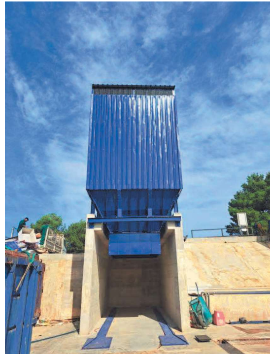
Imagem: Novo cais de receção de biorresíduos na Estação de Transferência de Lagos.
