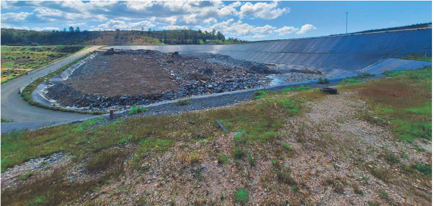
Imagem: Frente de trabalho no Aterro Sanitário.
